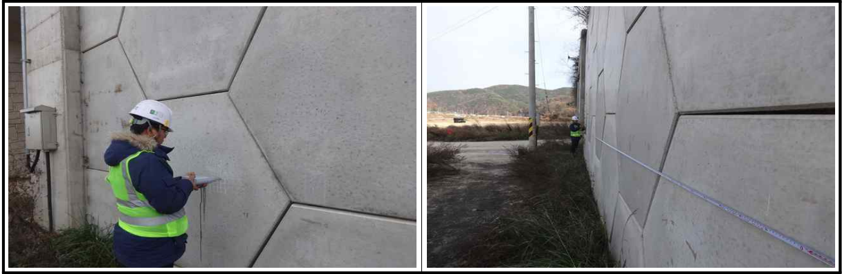
【그림 2.3.6】 슈미트해머를 이용한 반발경도시험 전경
